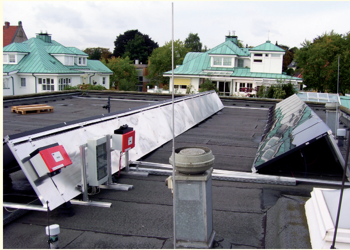
Photovoltaik-Leistungs- vergleich: Die erste der geplanten sechs Solaran- lagen auf dem Stadthaus Osna-brück. Photovoltaic bench- marking: The first of six planned solar collectors to be installed on the Osna- brück "Stadthaus".
